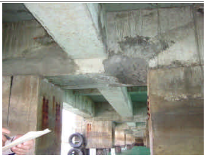
BL6-2 梁の補修状況
