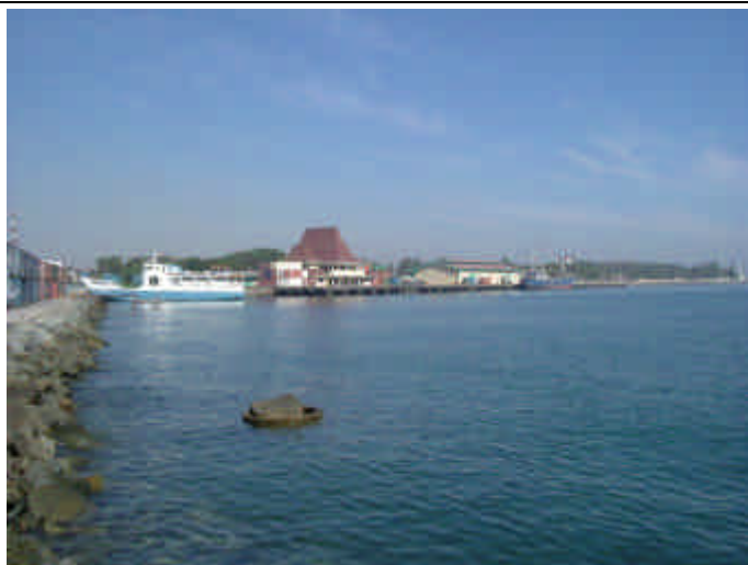
東コンテナターミナル護岸、フェリー埠頭
