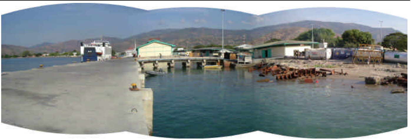
ブロック 6 , 8 棧橋、西コンテナヤード護岸
