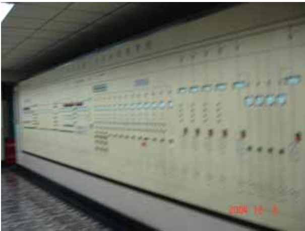
図表 126：冷蔵倉庫内温度コントロールシステムのパネル
