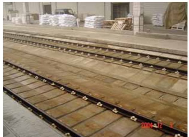
図表 121 : 構内のスラブ軌道
