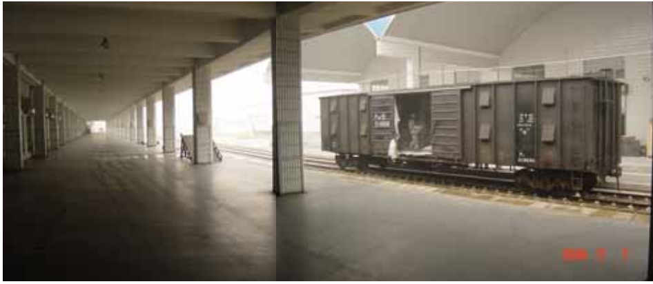
図表 117：冷凍庫内の立派なホーム
