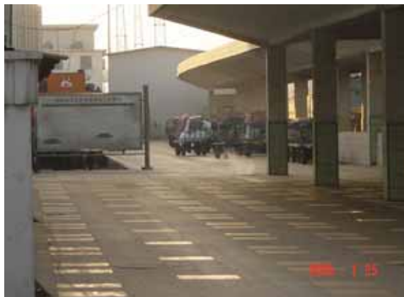
図表 52 : 濟南西駅内手小荷物積込ホームを遠くに望む (集荷トラックの荷卸場所)
