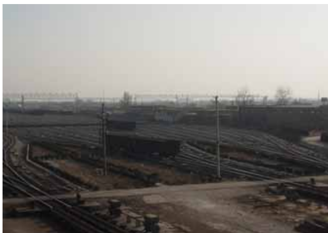
図表 48 : 指令所から見たヤード全景 : 貨車の編成作業
