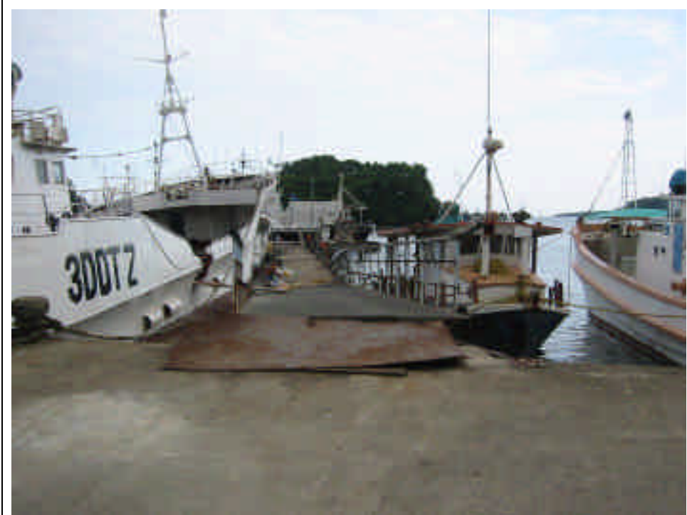
既存水産局ラミ栈橋（栈橋エプロン部・北側から望む） （手前：エプロン部、中央：渡り栈橋、奥：既存木製浮栈橋）
