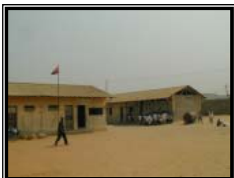
CB 造の既存教室（外観）
