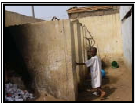
既存便所（外観）
