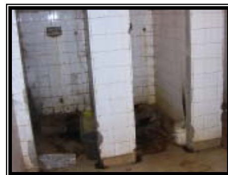
既存便所内部
