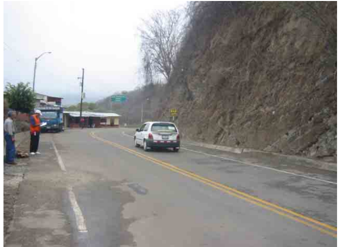
取付道路(ペルー側、幅員 11.3m)
