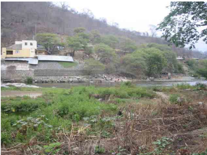
マカラ新国際橋、渡河地点(下流方向を望む、対岸がペルー)
