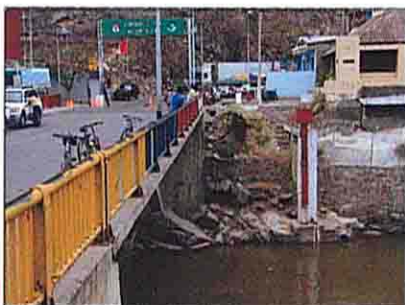
ペルー側橋台2
