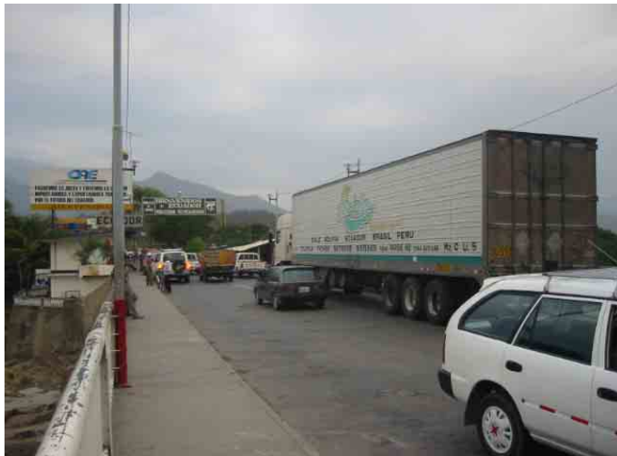
橋上の6軸セミ・トレーラー
