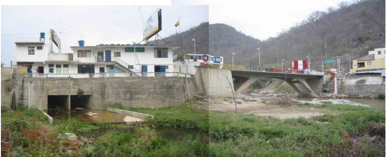
現橋全景（下流側より望む、左側がエクアドル、右側がペルー） エクアドル側約50mの盛土が河川敷に侵入しており、排水用ボックスカルバートが設けられている。
