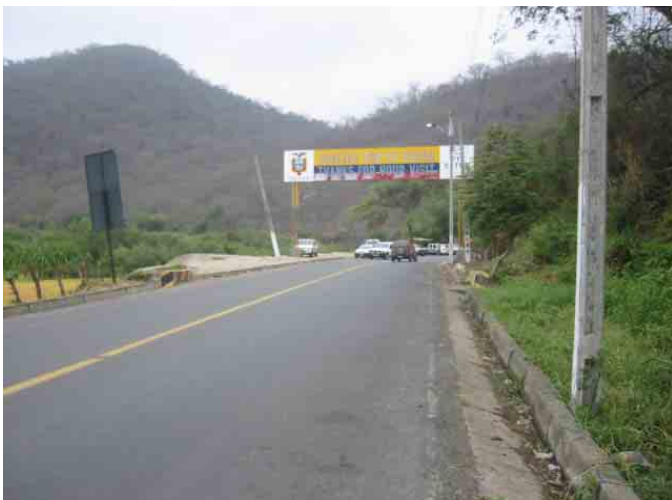
取付道路(エクアドル側、幅員 8.1m)
