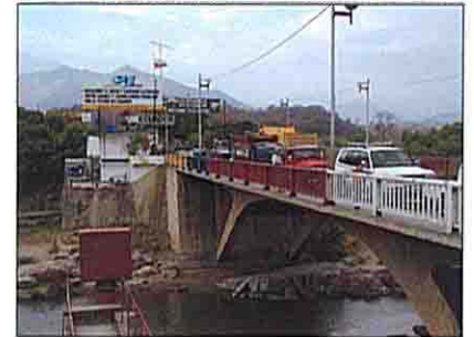
エクアドル側橋台1
