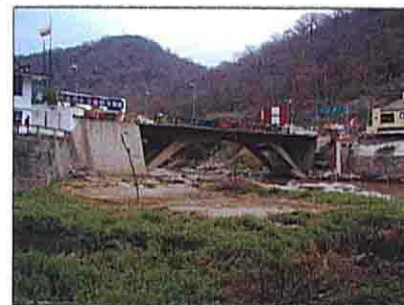
既設橋全景 (左側エクアドル)
