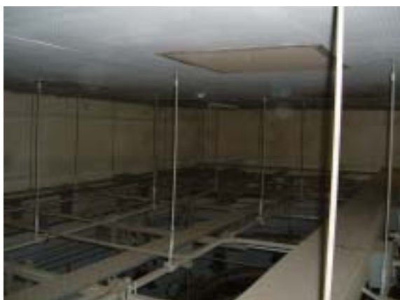
Photo 2.2-1 Fixations de soutien de l'éclairage de studio (sur grille)
