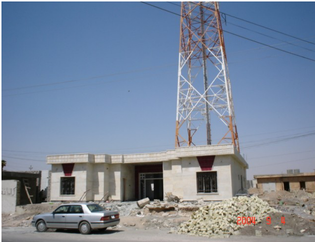
北ルートマイクロ波伝送路 Samara 無線局 局舎及び自立鉄塔（高さ：77m）
