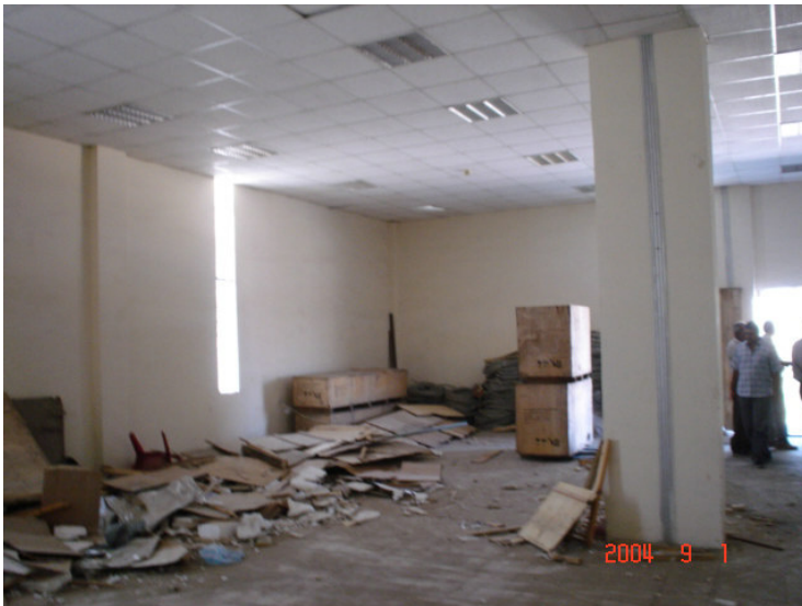
Ghadir 市内交換局 (Baghdad 市内) Thomson CSF 交換機 (30,000 回線) 被損傷交換設備の撤去作業
