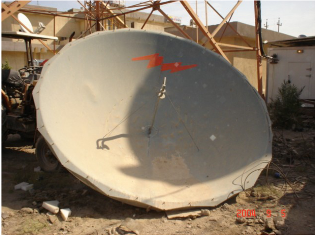
南ルートマイクロ波伝送路 Hilla 無線局 損壊した旧パラボラアンテナ
