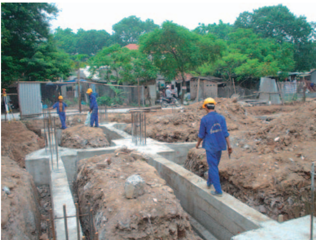
研修センター建設地
