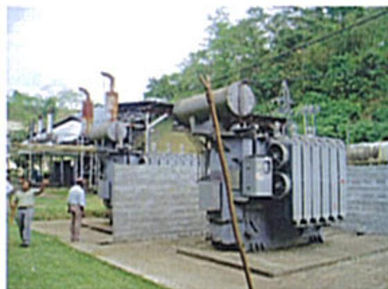
ホニアラ発電所内 33/11kV 変圧器
