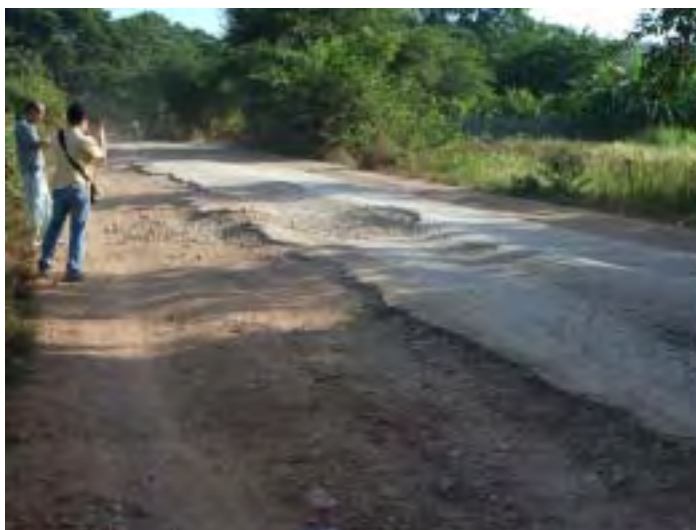
路盤施工が劣悪。雨期にはDBST 舗装表層に発生したポットホールから雨水が浸潤して路盤がさらに損壊する。
