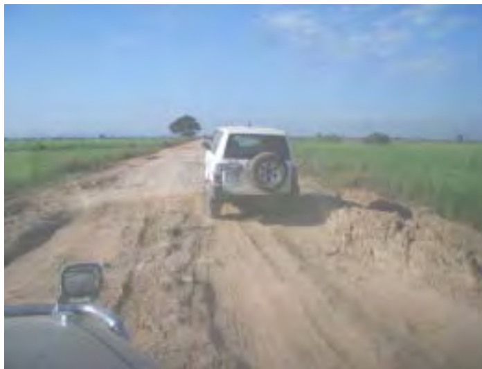
土道。路体材料は劣悪。雨期には泥濘化し車両通行は極めて困難となる。
