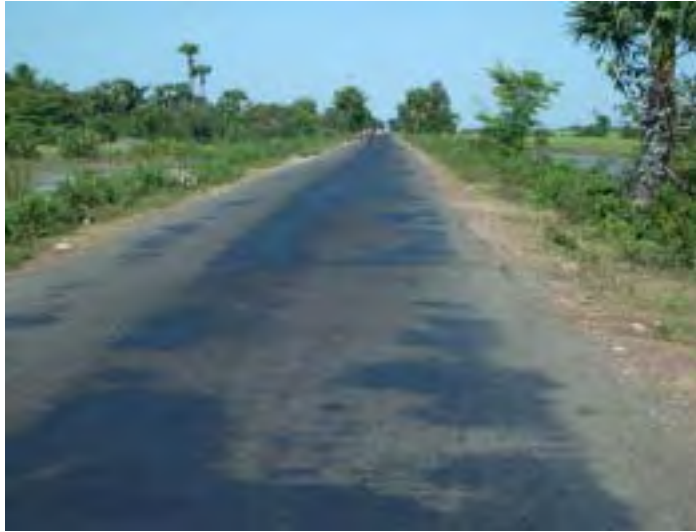
DBST 舗装道路。路肩部分から損壊が始まっている。
