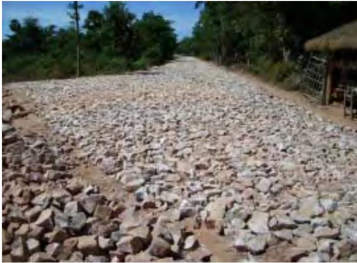
マカダム舗装施工中の地方道。
