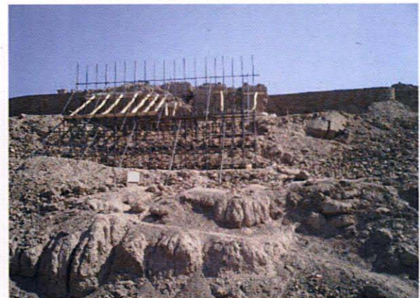
城壁の倒壊防止工
