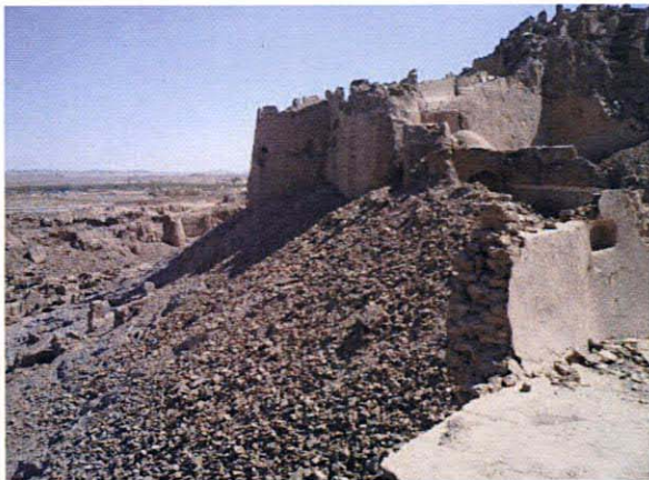
Garrison 部外側：崩壊状況
