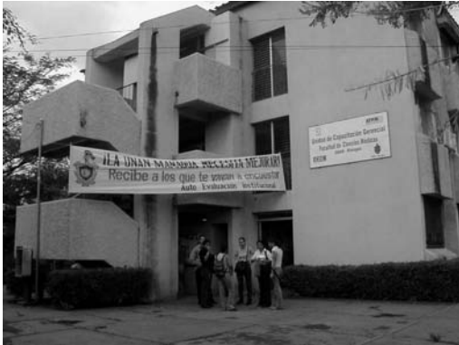
保健技術研究所本館
