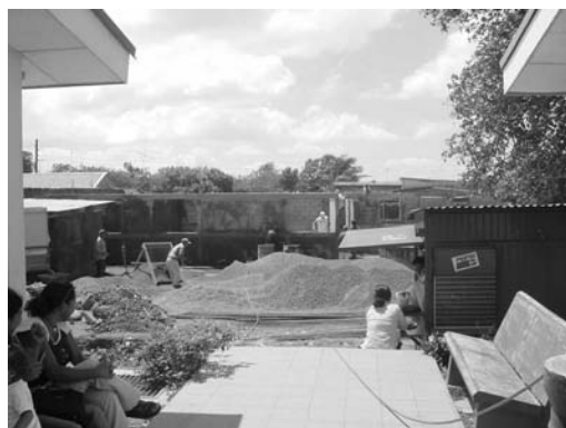
学生寮(建設中)
