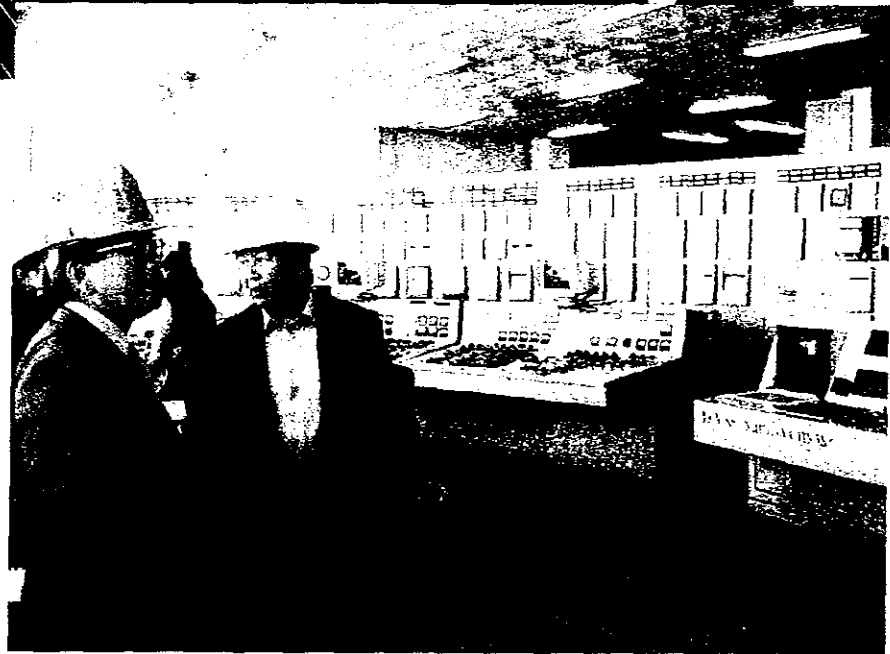
写真6 ウランバートル第IV火力発電所内部（古い設備を活用）
