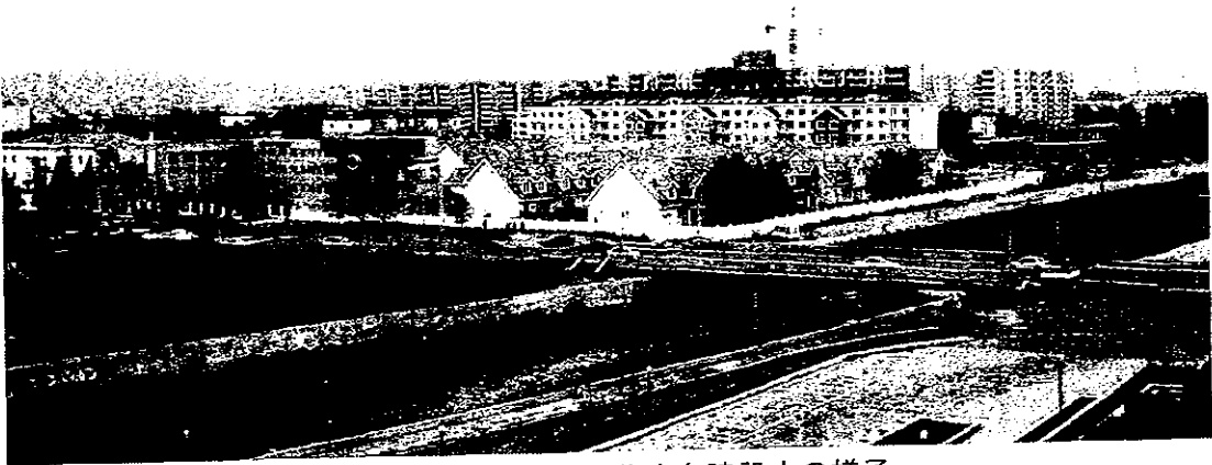
写真3 真新しい住宅と建設中の様子
