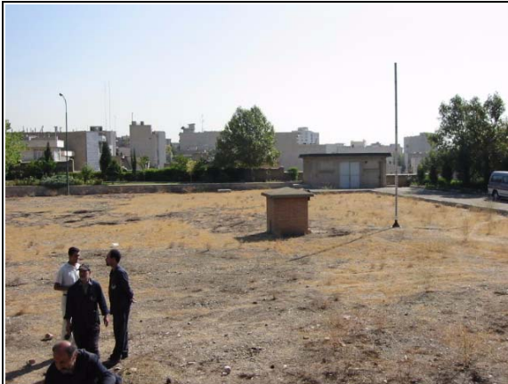
住宅地にある地下式配水池 (中央に見えるのが通気口)
