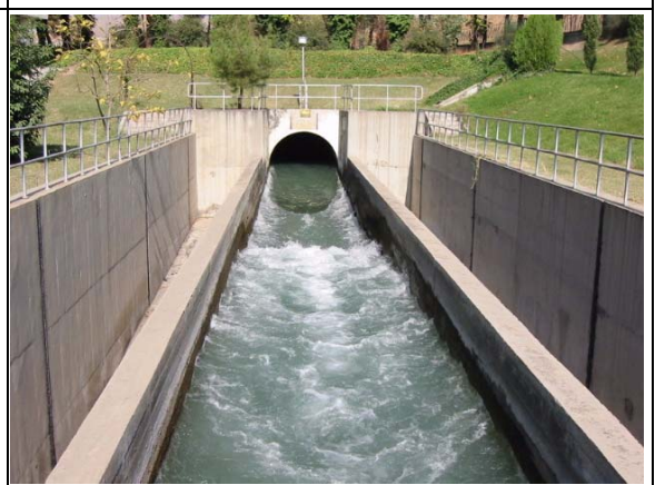
ラティアンダムから No.3 & No.4 浄水場への 導水トンネルの出口
