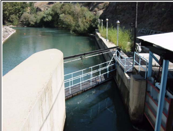
カラジダム下流のビラガン取水の取水口 (No.1 & No.2 浄水場へ送水)
