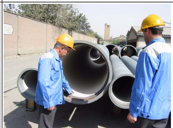
きれいに内面モルタルライニングされた ダクタイル鋳鉄管
