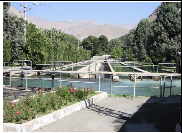
ビラガン取水の沈砂池
