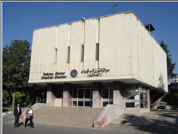
既設コントロールセンター外観 (新コントロールセンターを SCADA システ ムの導入に合わせて建設中)
