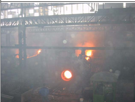
市内にあるダクタイル鋳鉄管工場 (L.M.I 社) の管鋳造風景
