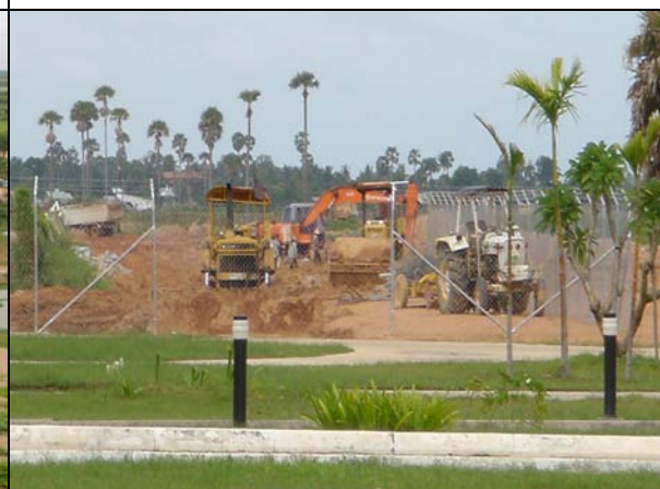
写真-24: シェムリアップ空港拡張工事
