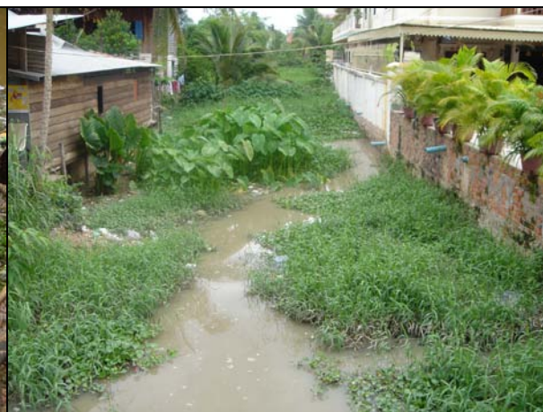
写真-20: 市内排水路
