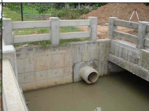
写真-6: （雨水下水）合流式排水路
