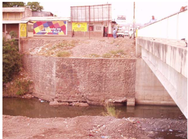
(護岸基礎の洗掘)
