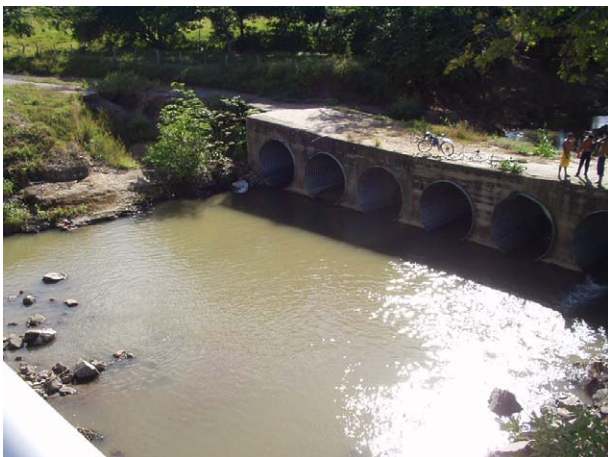
(本橋上流に存置された迂回道路下流が洗掘している)
