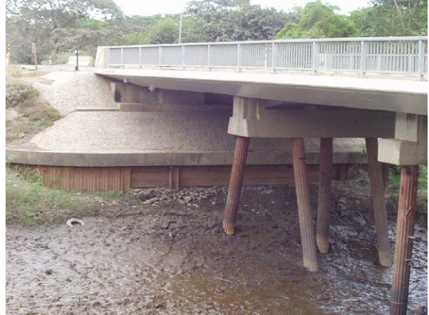
(橋台護岸背面の土砂流出)
