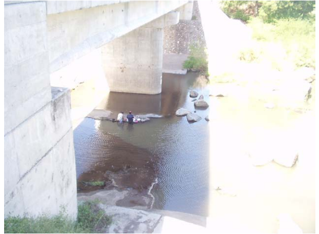
(護床工の損傷を確認する必要がある)
