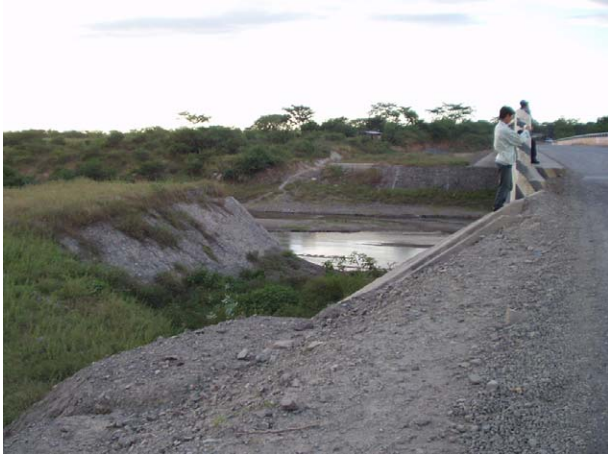
(存置された旧橋の取り付け道路)
