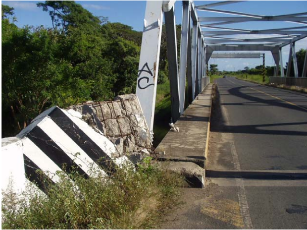
(車両用防護柵の損傷、塗装の劣化)
