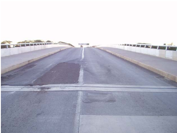
(舗装の損傷)
