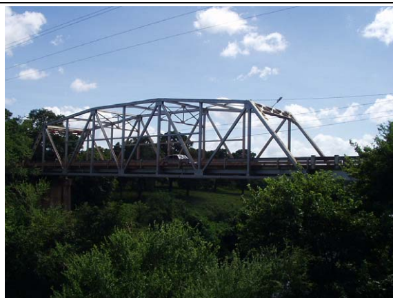
写真6-8 ラ・トンガ橋 (側面)
