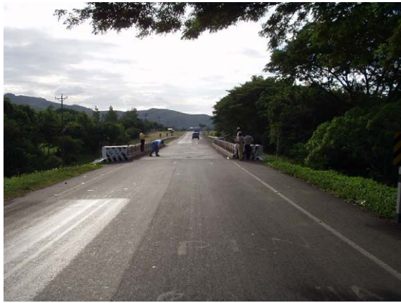
写真2-1 エル・ラマ側より全景（正面）
