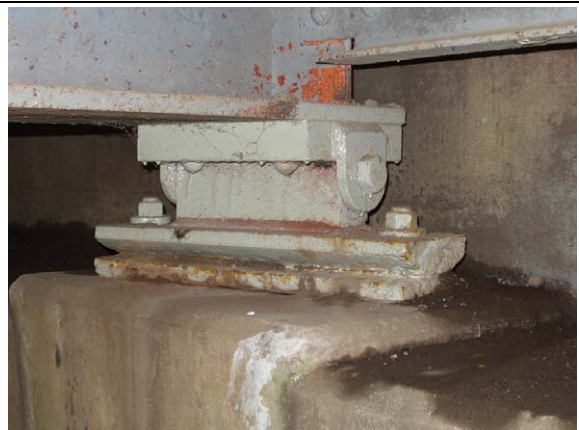
写真 5-8 不適切な塗装により機能不全となった支承
