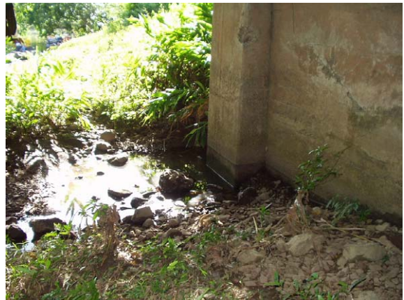
写真 5-6 橋脚の局所洗掘
