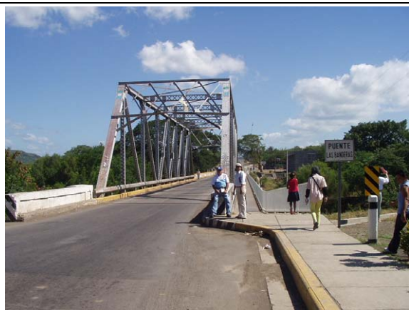
写真6-1 ラス・バンデラス橋 (正面)
