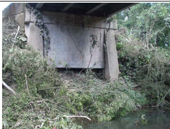
写真46 護岸の沈下により露出した橋台
