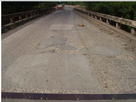
写真3-3 補修を重ねるコンクリート床版表面
