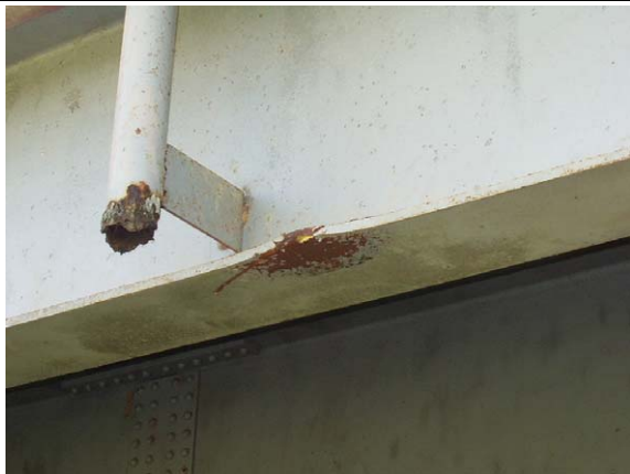
写真 5-3 主桁の部分的な変形
