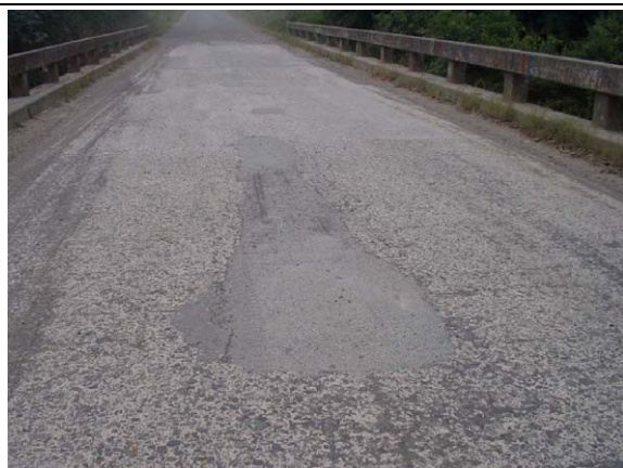
写真43 補修を重ねるコンクリート床版表面
