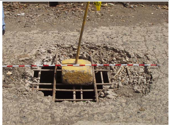
写真3-4 コンクリート床版の抜け落ち
