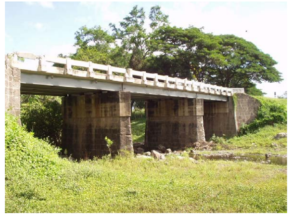
写真2-2 マナグア側より全景（側面）
