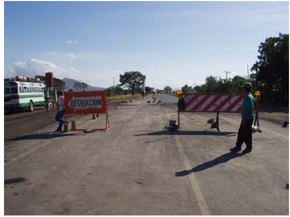
写真1-2 一部工事中の国道7号線 (サン・ベニート付近)
