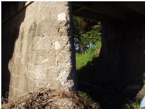
写真2-5 河川流下により磨り減った橋脚
