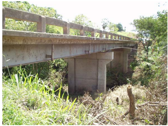
写真3-2 エル・ラマ側より全景（側面）
