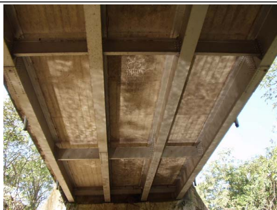
写真44 錆汁を伴うコンクリート床版のひびわれ
