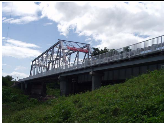
写真6-4 テコロストーテ橋 (側面)
