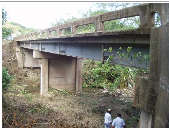
写真42 エル・ラマ側より全景（側面）
