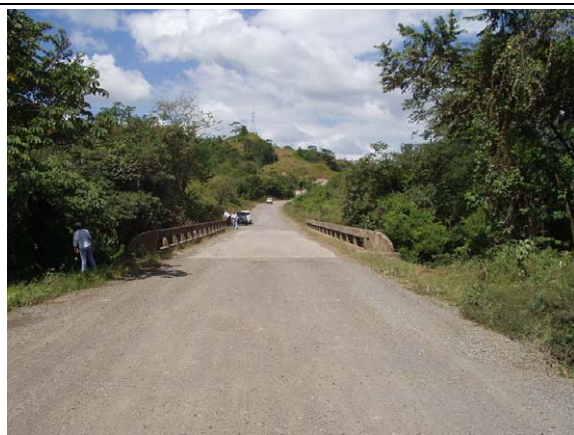
写真41 エル・ラマ側より全景（正面）
