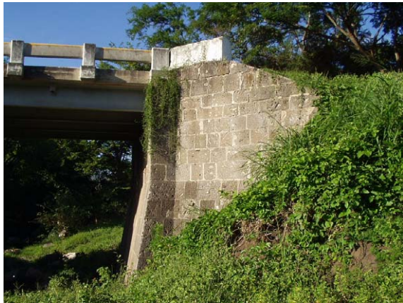
写真2-3 耐震性に劣る石積み橋台
