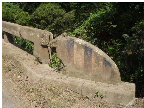
写真47 車両衝突により損傷した高欄
