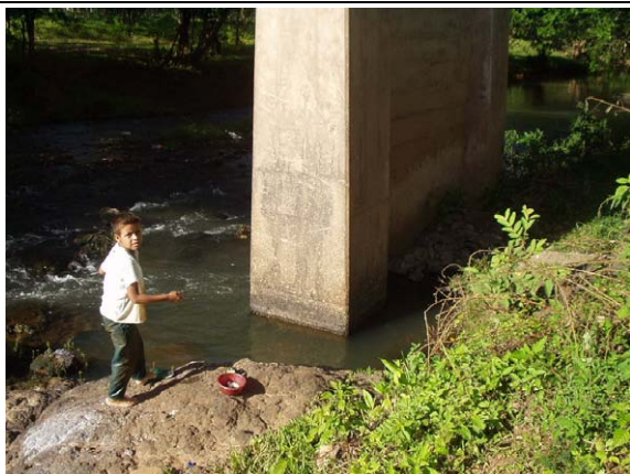
写真 5-7 橋脚の局所洗掘
