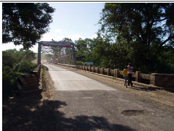
写真6-7 ラ・トンガ橋 (正面)
