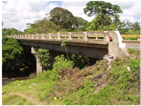
写真 5-2 エル・ラマ側より全景 (側面)
