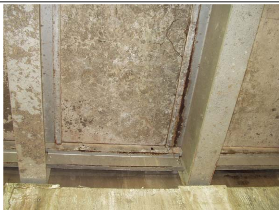
写真45 主桁フランジの腐食
