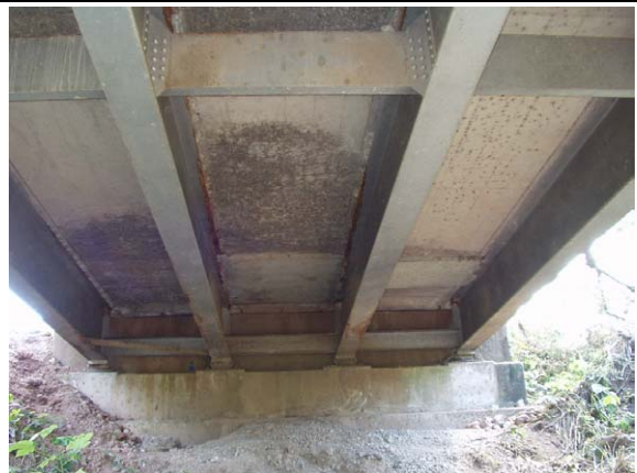
写真3-6 暫定的に補修されたコンクリート床版
