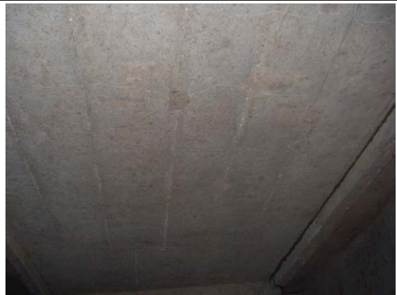
写真 5-4 健全なコンクリート床版
