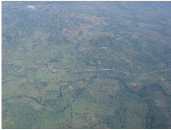
写真1-1 国道7号線 (フィガルパ付近)
