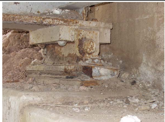
写真3-8 腐食により機能不全となった支承
