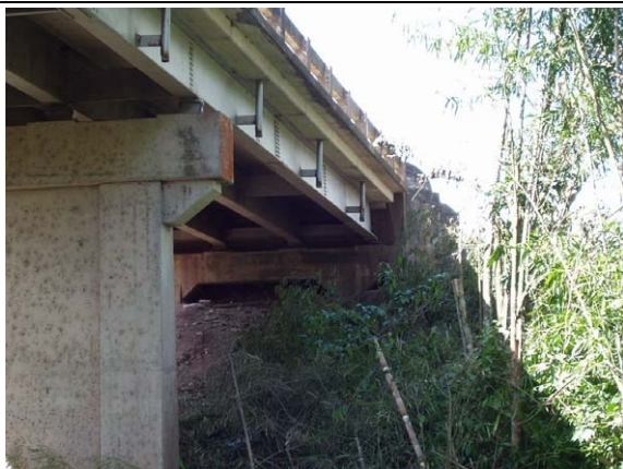
写真3-7 護岸沈下により露出した橋台
