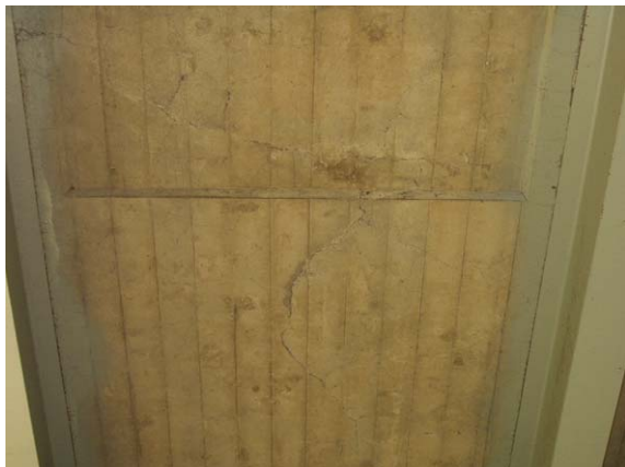
写真2-7 床版下面のひびわれ
