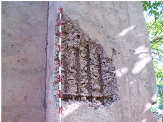
写真 5-5 施工不良による橋脚の豆板
