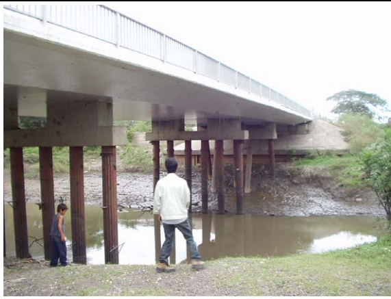
写真7-9 エステロ・レアル橋 (補強) (NIC-24)
