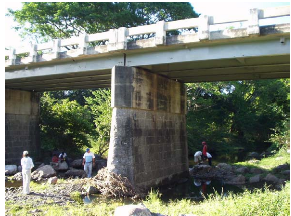
写真2-4 耐震性に劣る石積み橋脚
