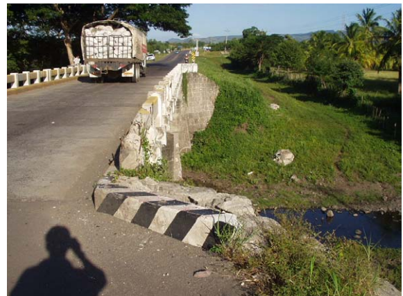
写真2-8 車両衝突による高欄の損傷
