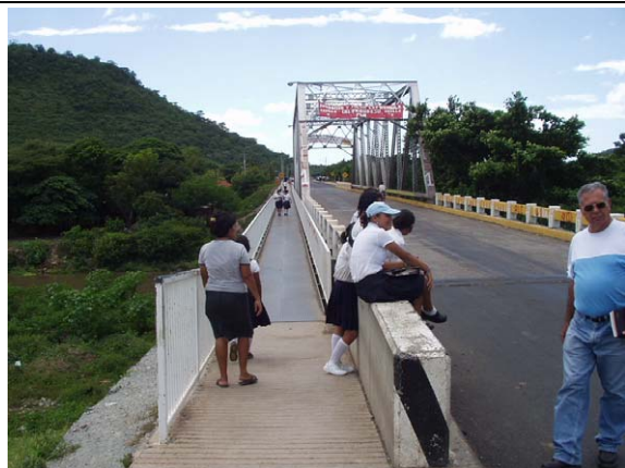
写真6-3 テコロストーテ橋 (正面)
