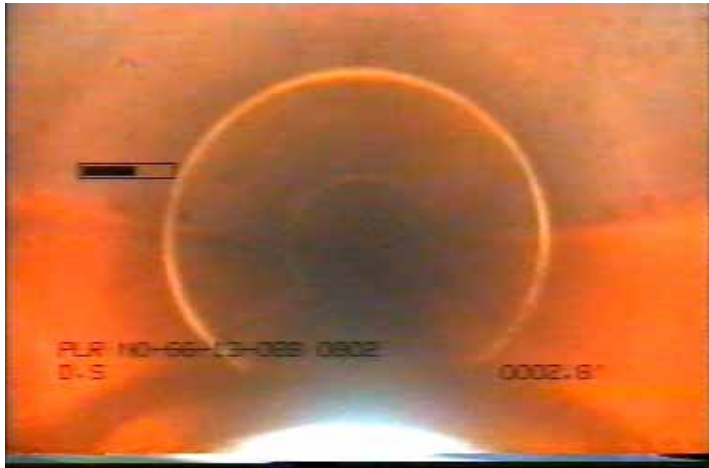
写真-13：清掃後の下水管の内部の写真
