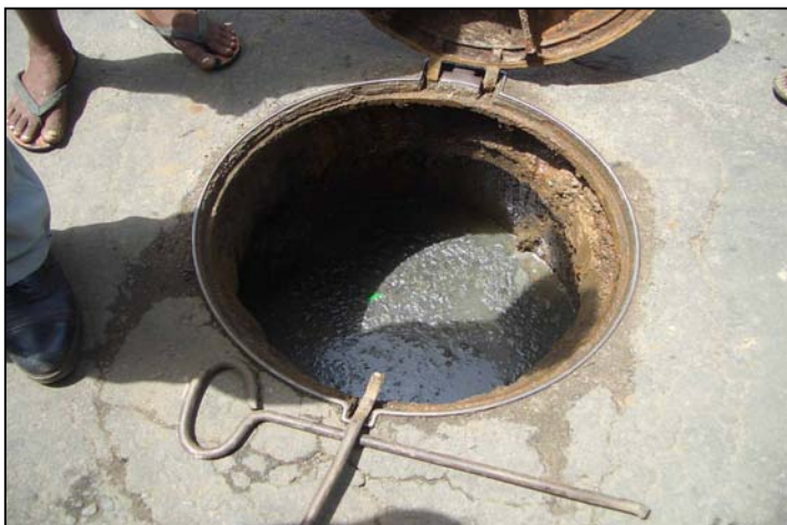
写真-08：市内のマンホール
