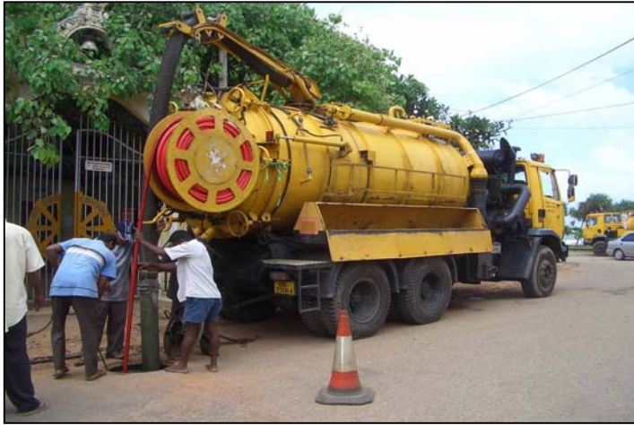
写真-09：NWS&DBによる下水管清掃作業
