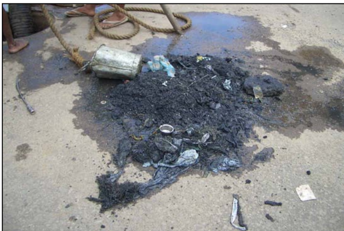
写真-11：マンホール内に堆積していた土砂/ごみ
