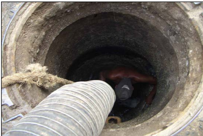
写真-10：CMCによる下水管清掃作業
