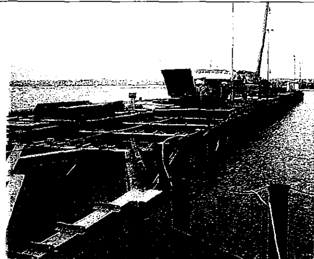
棧橋上部工改修状況
