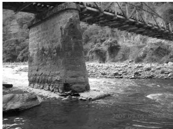
石材と巨石コンクリートによる重力式橋脚
