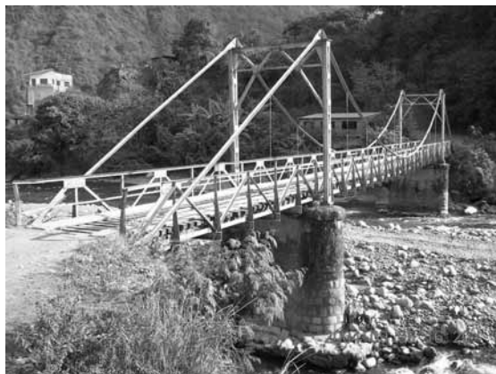
1933 年に建設された鋼桁橋
