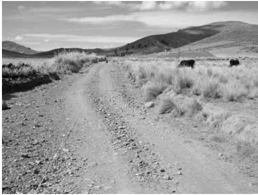
側溝未整備区間
