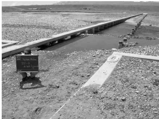
PS-6 の現況 (左岸側)
