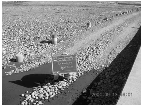
PS-5 の転圧された堆積土砂
