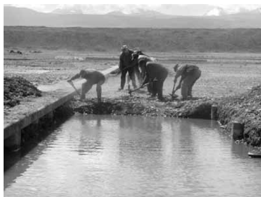
増水後の潜水橋(河床材料が堆積している) 出典:UCPA
