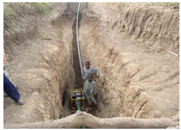
地下水灌漑地区に設置されたポンプ (カテリ・ミカル地区)
