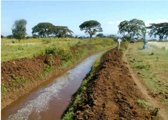
改修工事により土砂が取り除かれた幹線水路
