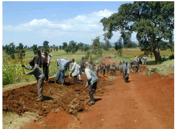
道路沿いの住民によるがり補修作業
