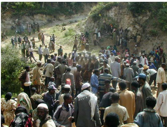
女性を含む多数の周辺住民が参加した丸木橋の補修
