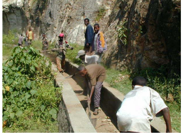
組合員による水路内の堆砂除去作業
