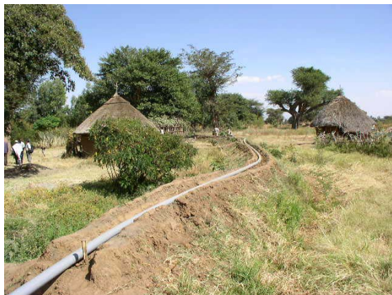
送水ロス軽減のため一部水路にパイプを使用した カクマ地区
