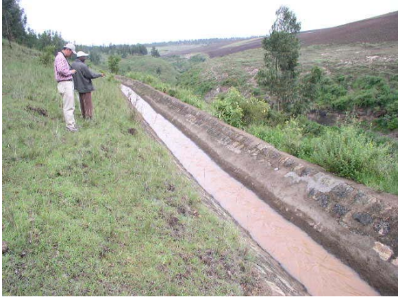
OIDA 職員による既存灌漑施設インベントリー調査
