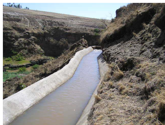
改修後の幹線水路
