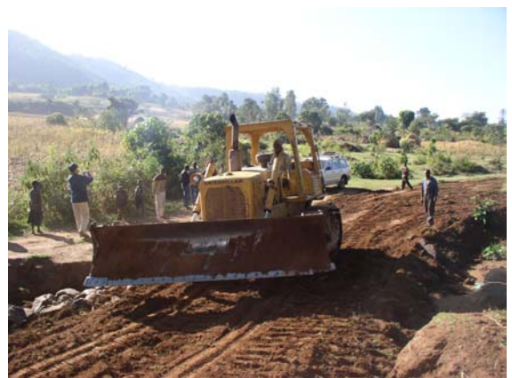
OIDA 重機による道路改修工事
