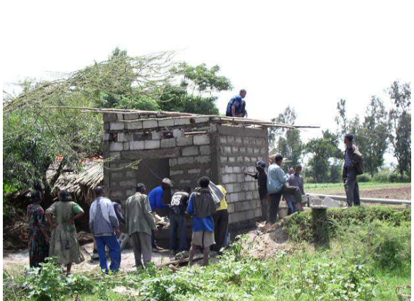
ポンプ小屋の建設に参加する組合員
