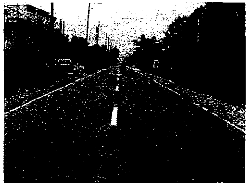
ナイク地区付近での道路状況
