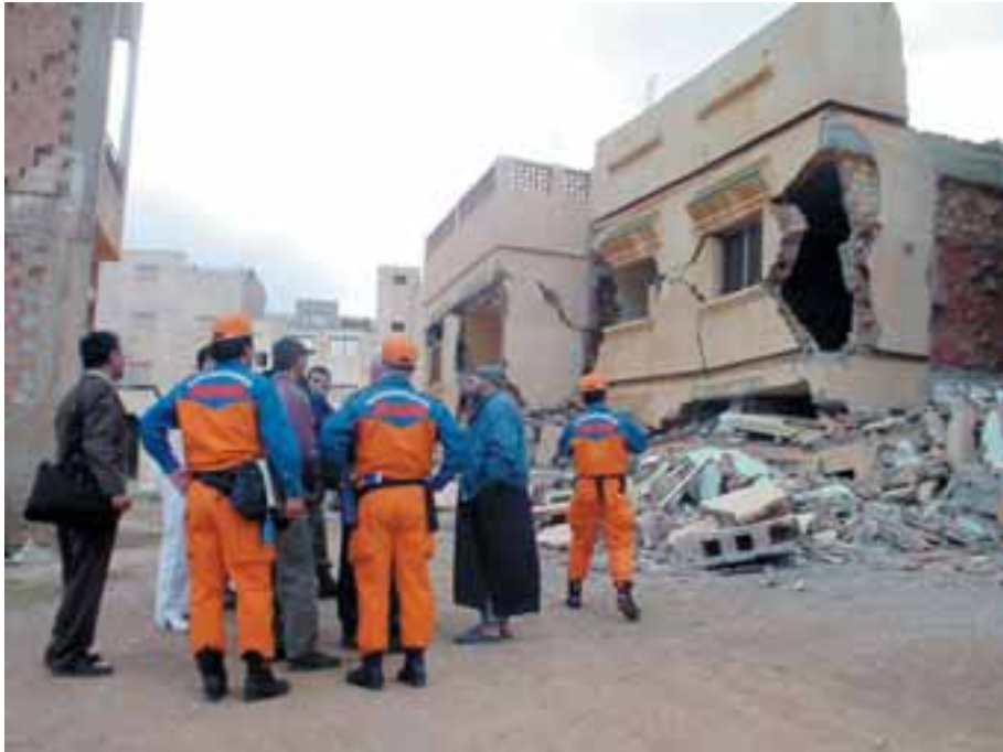
壊れた建物すでに救助済み
