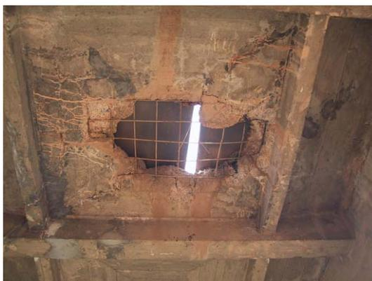
ブレックハウ橋 床版の損傷
