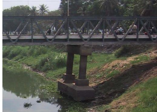
第二タクマウ橋 橋脚の損傷 (傾斜)
