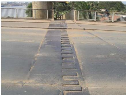
鋼桁部伸縮継手
