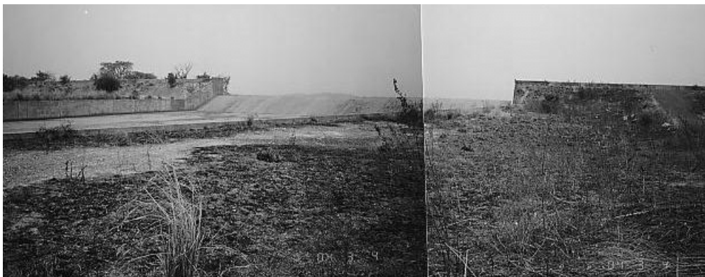
写真 8-6 Tono ダム余水吐
