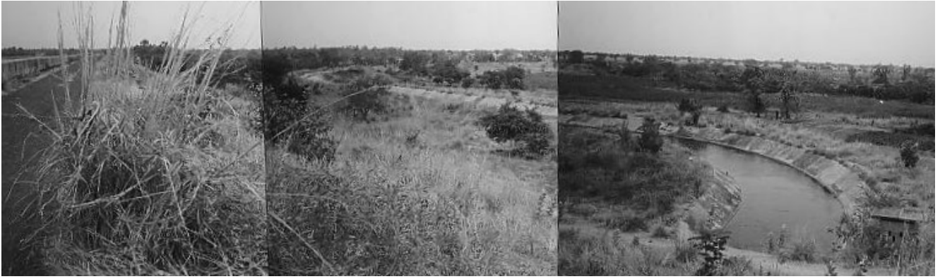
写真 8-5 Tono ダム直下流灌漑水路
