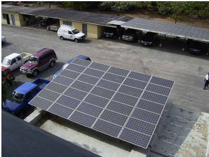
Ministry of Energy(MOE)の建物の様子（エントランス=手前、駐車場=奥の屋根にソーラーパネルを設置している）
