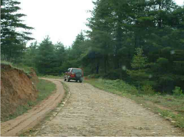
完成した農道（ブントアン県）：車道幅員の両側に舗装止石が敷かれ、碎石が外に出ない工夫がされている
