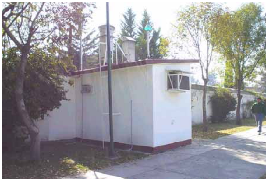
Estación ubicada en un predio dentro de una escuela
