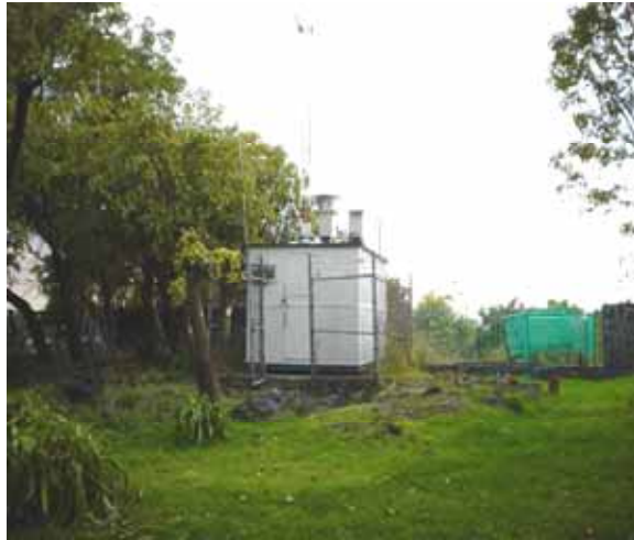
Estación Obstruida por Vegetación
