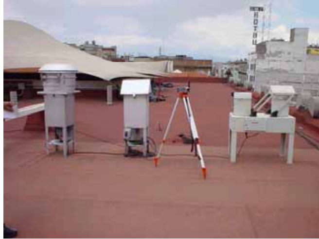
Instrumentos de medición sobre una azotea
