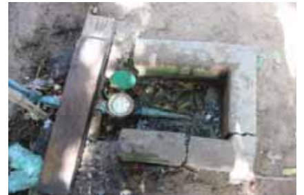
PPWSAの配水管網から民間業者が引 いてきた水道管(3,000R/m3)
