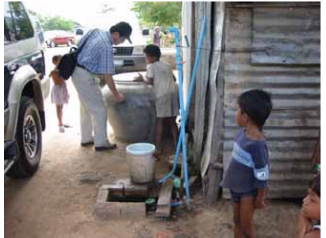
PPWSAの配水管網から民間業者が引 いてきた水道管(3,000R/m3)
