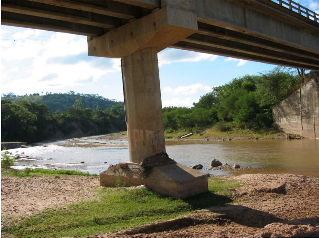
写真 2-1 タルマ橋橋脚の露出状況
