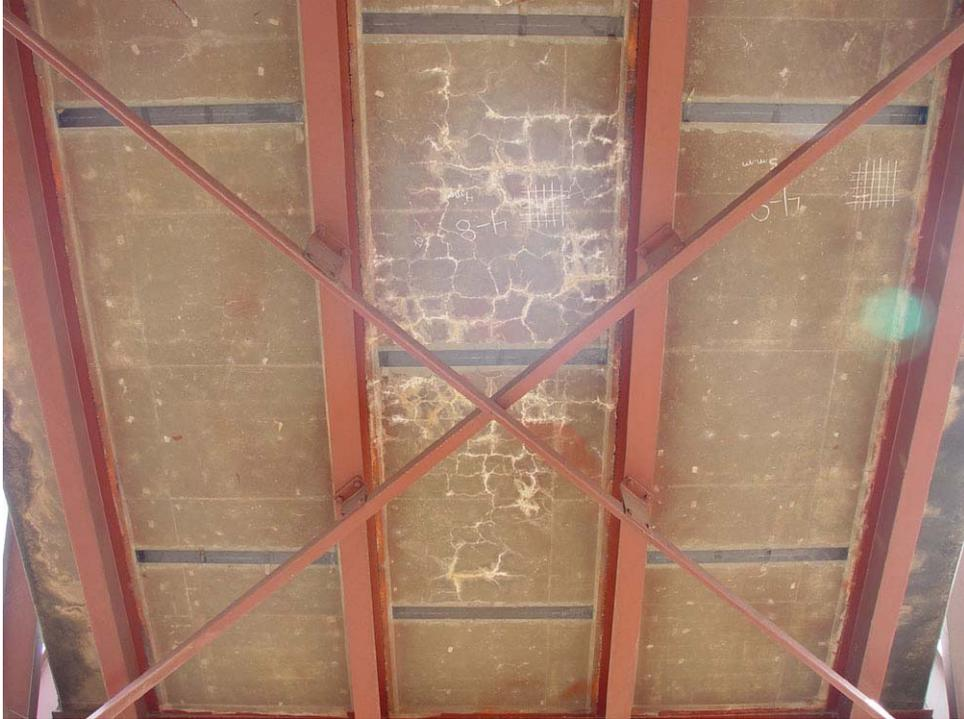
写真(7) 床版の損傷状況
