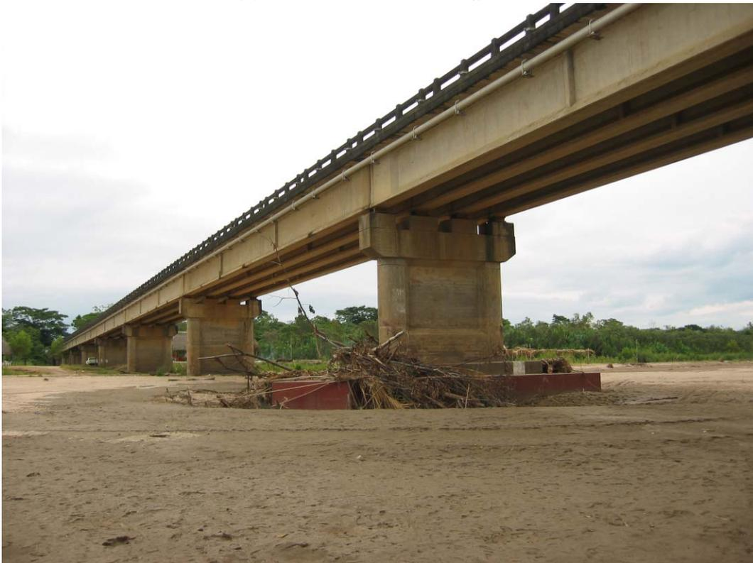
写真 2-2 ヤバカニ橋橋脚の洗掘対策とかさ上げ状況
