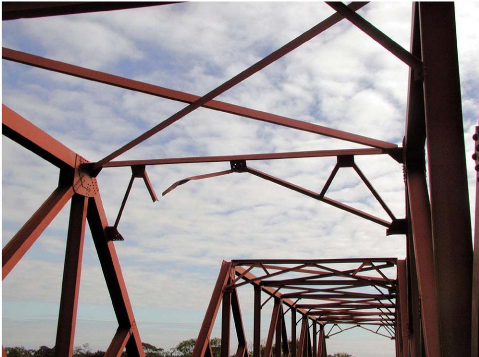
写真(3) 破断した橋門構
