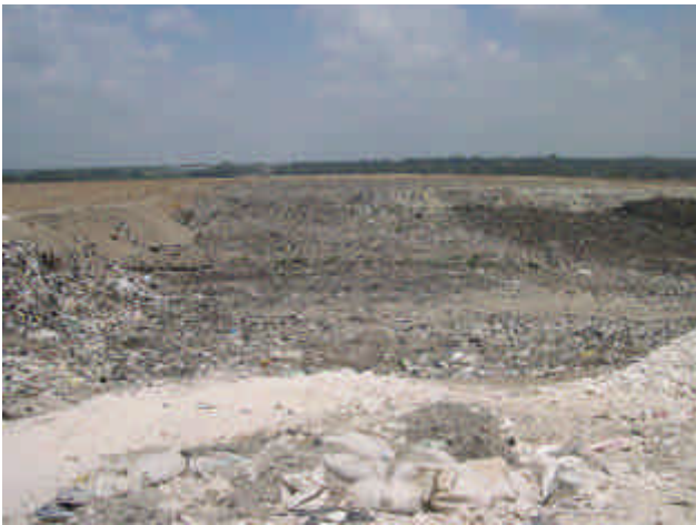
改修後の処分場
