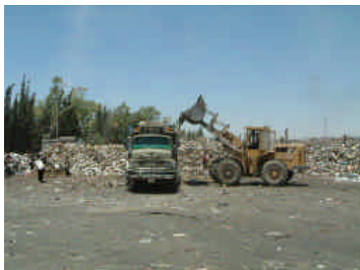
図 6.2-2 中継基地でのごみの積み込み
