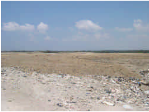
ゾーン 1,2 : 改修後の状況
