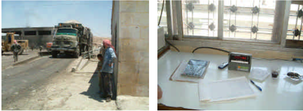
図 6.2-3 ウェイブリッジ(左)と指示計(右、買い替え品)
