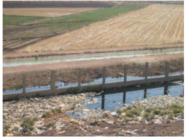
浸出水の溜り池、すぐ隣に農業用水路が流れている。
