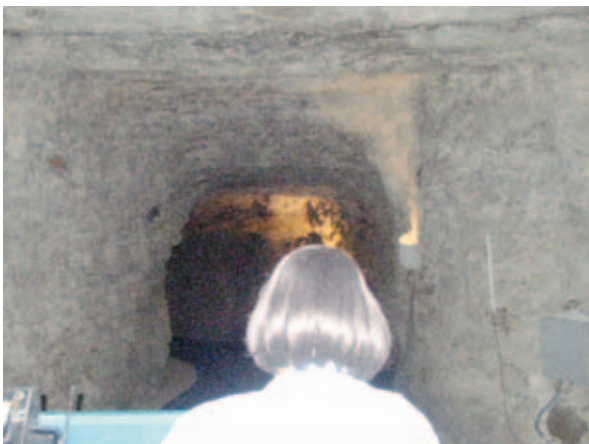
写真5 電動トラムが通る坑道 鍾乳洞は電動トラムを通すために壁が四角に削りこまれている。
