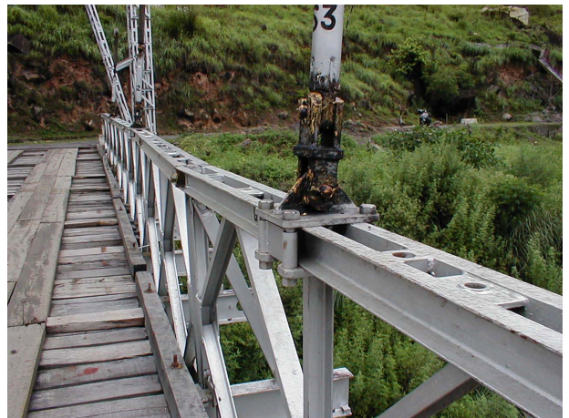
座屈した補剛トラス
