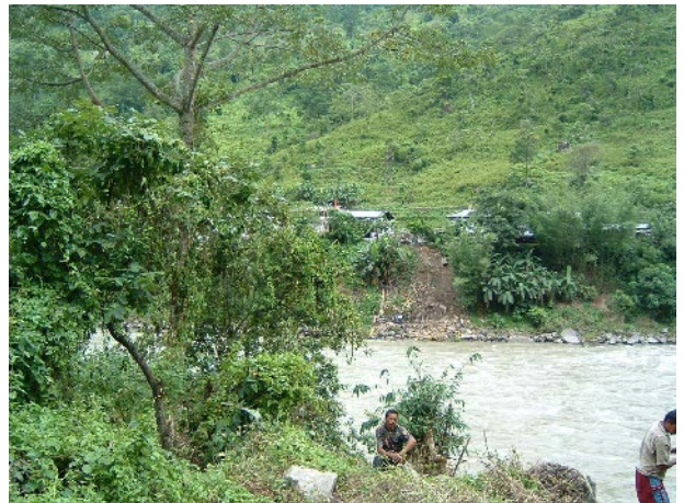
右岸側上流架橋地点状況 (4)
