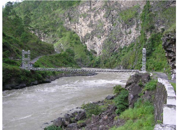
左岸下流からの橋の全景 (2)
