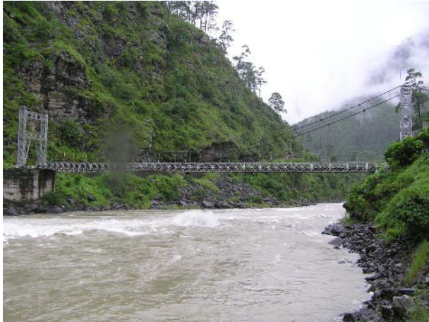
右岸上流からの橋の全景 (1)
