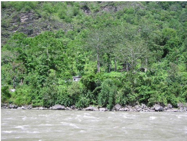
左岸側上流架橋地点状況 (3)
