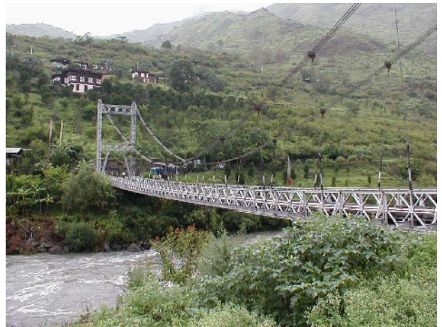
左岸下流からの橋の全景 (2)
