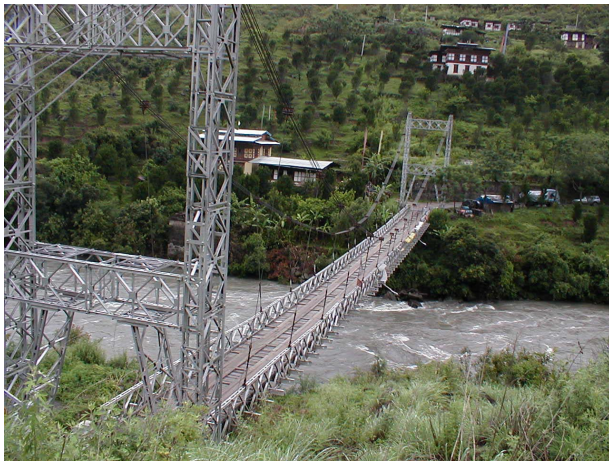
左岸上流からの橋の全景 (1)
