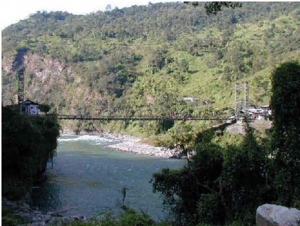
乾期左岸上流からの橋全景 (1)
