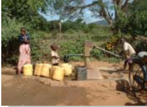
ハンドポンプ型給水施設
