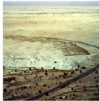
道路の被害防止柵
