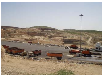
中継施設全景
