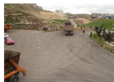
中継施設全景
