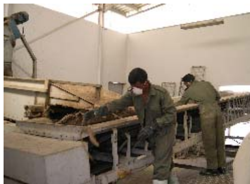
5.6 不純物取り除き作業(バイオガスプラント)
