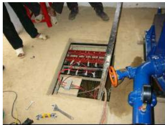
ダミーロード据付図 (放水庭内)
