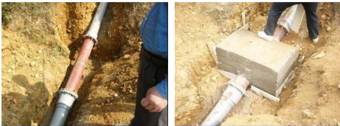
図 3-20 固定台部分の鋼管との接続例
