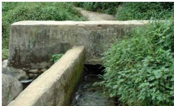
図 3-6 オリフィス取水口の例
