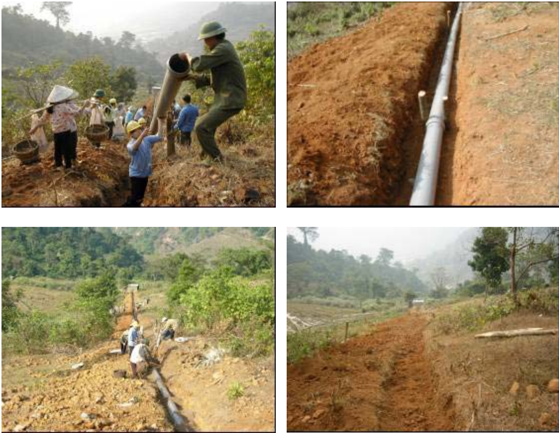
図 3-21 水圧管路施工状況
