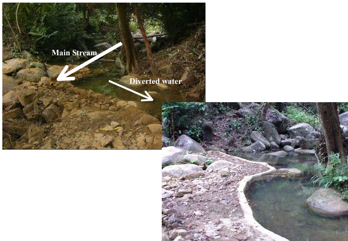
図 3-4 石積取水堰および取水口参考例
