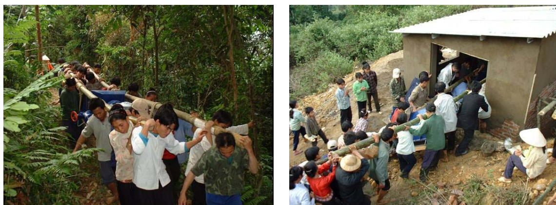
図 4-1 水車発電機の運搬作業
