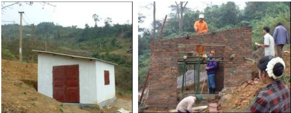
图 3-23 發電所施工狀況
