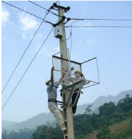
図 6-1-5 区分開閉器 施工状況
