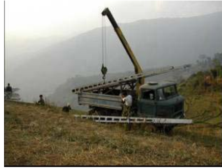
2.電柱積み下ろし（資材置き場）
