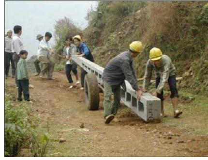
3.電柱移動（資材置き場～村道）
