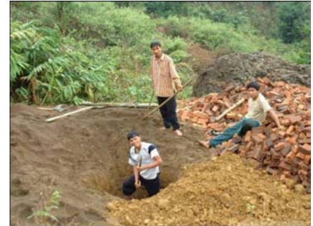
4.電柱穴掘削
