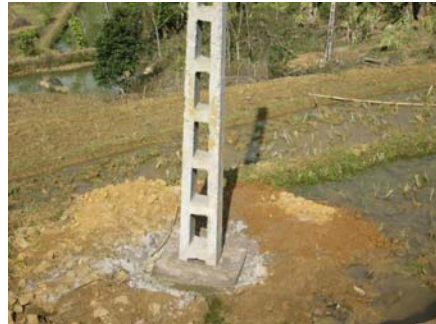
6.電柱基礎（棚田）
