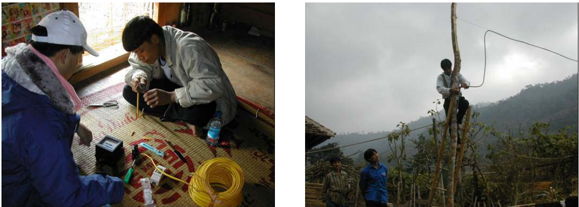
図 5-7-4 電力量計の結線方法（左）と引込み線施工（右）のトレーニング
