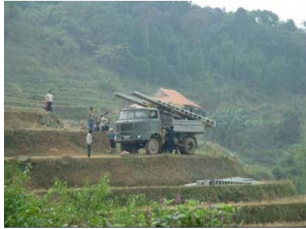
1.電柱搬入（トラック運送）
