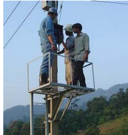
図 6-1-5 区分開閉器 施工状況
