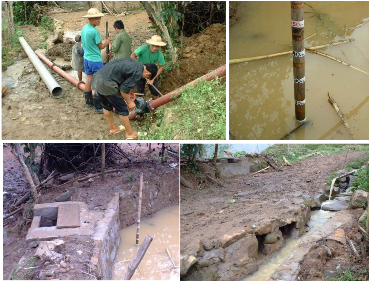
図 6-1-3 調整池放流設備施工状況
