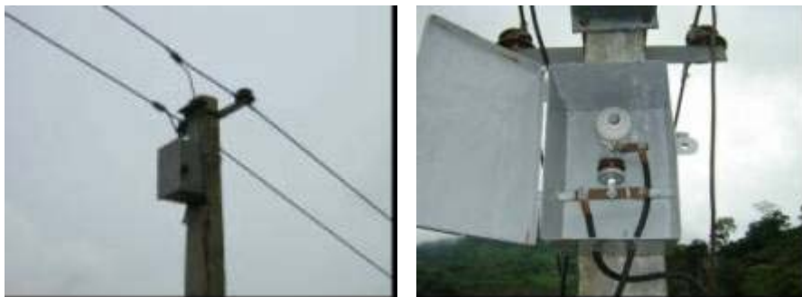
参考： 避雷器 (Lightning Arrester)
