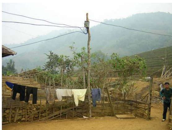
図 3-5-4 主要引込み設備（左：引込柱、右：電力量計とブレーカー）
