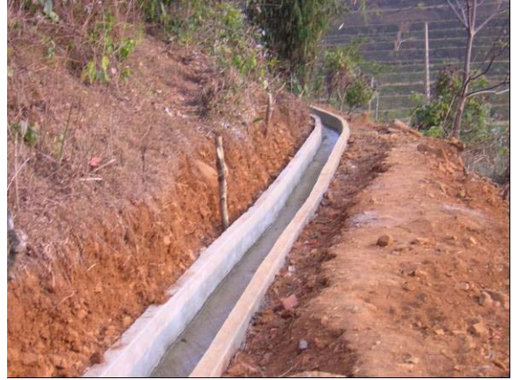
導水路（新設部分）
