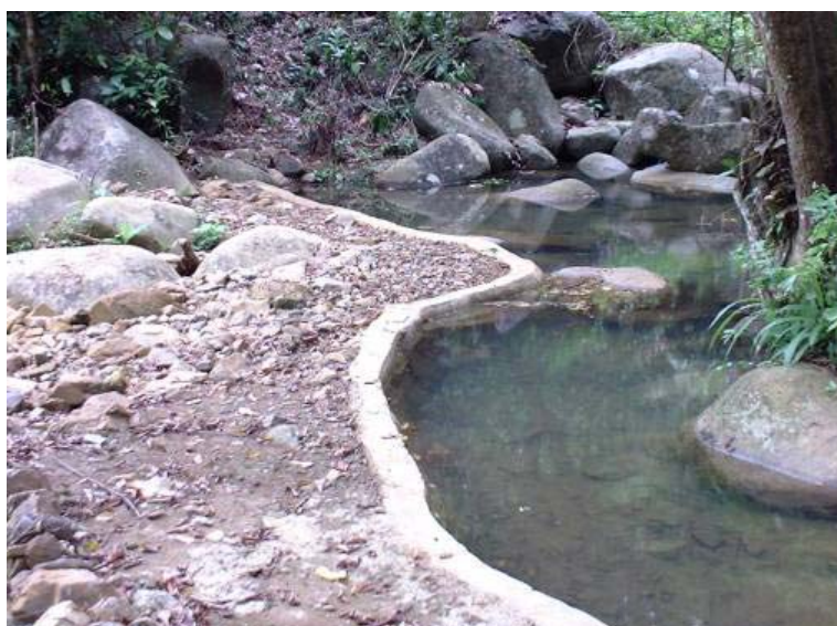
図 3-3-1 改修後の取水堰
