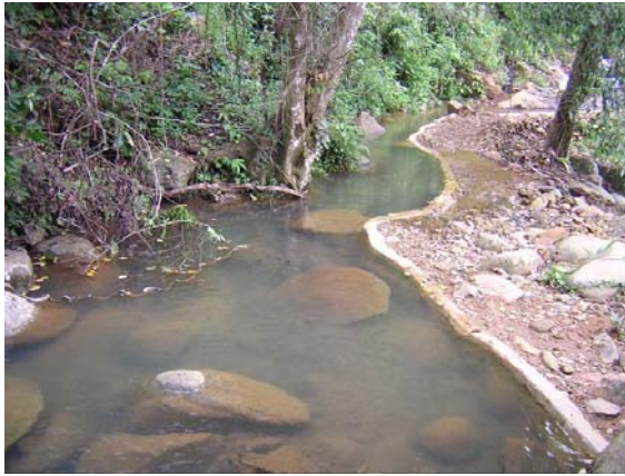
取水堰（住民施工）
