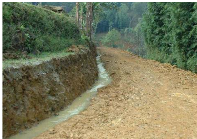
図 3-3-3 改修後の既設水路
