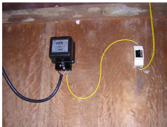
図 3-5-4 主要引込み設備（左：引込柱、右：電力量計とブレーカー）
