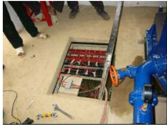
ダミーロード据付図（放水路内）
