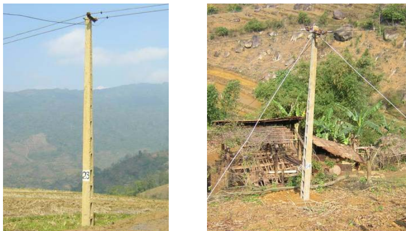
図 3-5-3 装柱状況（左：シングルアーム、右：ダブルアーム）
