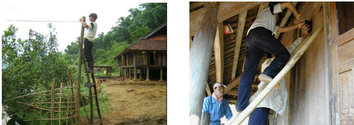
図 3-5-5 引込線工事（左：引込線の架線、右：電力量計の取付）
