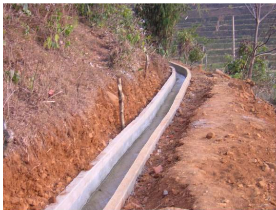
導水路（新設部分）
