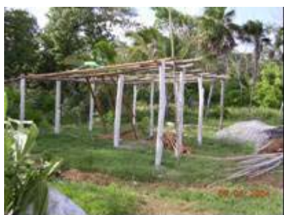
Nueva Construcción para acopio material separado
