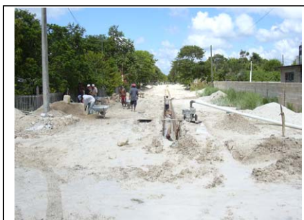
Trabajos de Instalación de la Línea de Drenaje
