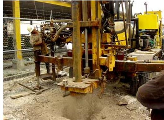
*Con base en la investigación geofísica, se construyeron pozos a diferentes profundidades con el fin de confirmar la litología del acuífero, la distribución de las fracturas, la presencia de cavidades, la interfase entre el agua dulce-agua salina, y la calidad de las aguas.*
