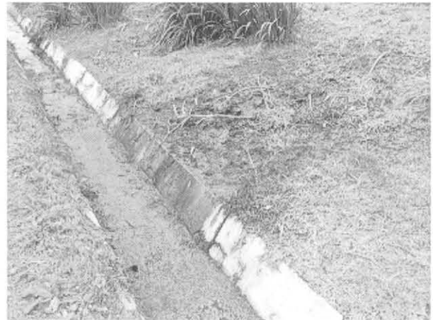
ゴミ埋立地からの浸出汚水が側溝に貯まっている様子
