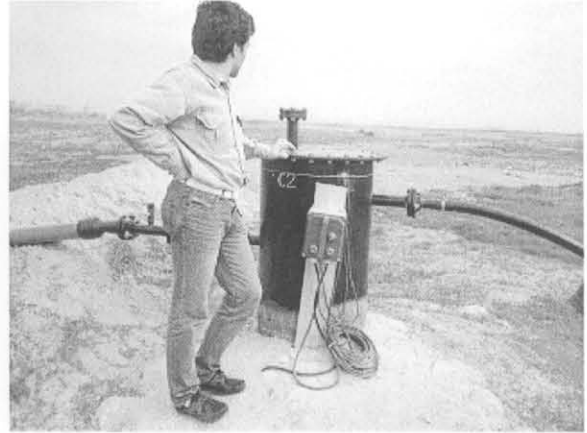
タイプ2：内部に汚水吸引ポンプがついていて吸引された汚水は左手のホースで処理に回され、ガスは右手のホースで上記の燃焼施設に回される
