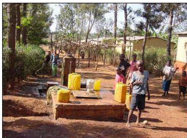
上流河川水を利用した自然流下式水道 UNHCRが建設した避難民定住化集落の水道施設 9km上流の沢水からパイプで送水。村毎に水栓が 管理され、1家族1年600Frwを納めている。 料金は郡水管理委員会で管理されている。 ニャツブイエ郡 / Nyarubuye / Ibanda
