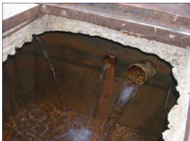
上流河川水を利用した自然流下式水道 UNHCRが建設した避難民定住化集落の水道施設 9km上流の沢水からパイプで送水。村毎に水栓が 管理され、1家族1年600Frwを納めている。 料金は郡水管理委員会で管理されている。 ニャツブイエ郡 / Nyarubuye / Ibanda
