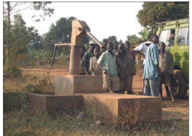
修復要請の故障井戸('88無償資金, -18) パーツが盗まれ故障したまま
