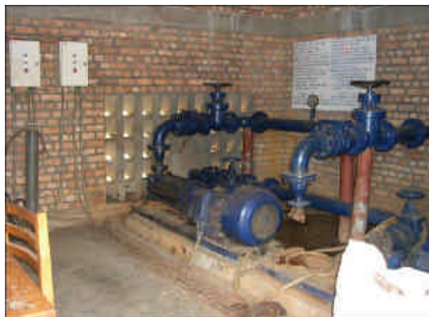
湧水をポンプアップする給水施設 (SAKE System) 同左。電力はElectrogazの商用電力使用 4ヶ月前に故障。資金提供を要請中。 ミレンゲ郡 / Nogoma / Bakokoza
