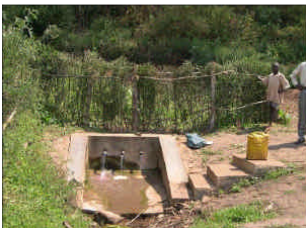
EUの無償援助で建設された保護湧水 (改良泉) ルワマガナ市/ Mwulire / Gisanza
