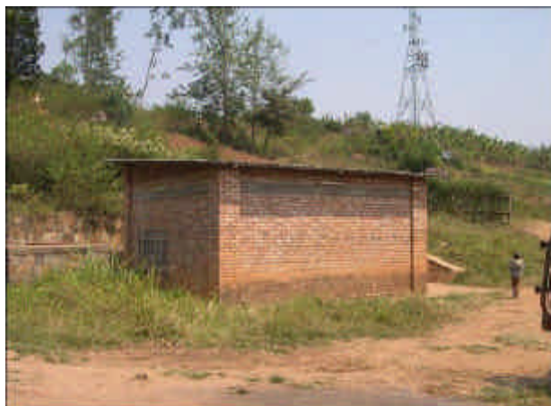
湧水をポンプアップする給水施設 (SAKE System) 同水源は保護湧水点としても利用されている 8,000人利用 ミレンゲ郡 / Ngoma / Bakokoza
