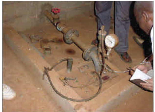
'87無償資金による給水システム(Nyankora) 1999年に水中ポンプが故障したが、2002年に 代替のポンプを購入し、入れ替えた。 容量が小さく、揚水時間が増し、電気代増加。
