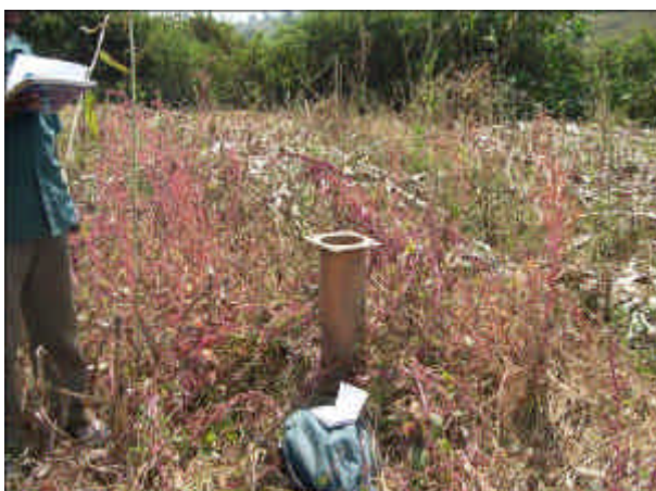
修復要請の故障井戸('88年度無償IV-15) ポンプヘッドは盗られ、内部は土砂で埋まり 放棄されている
