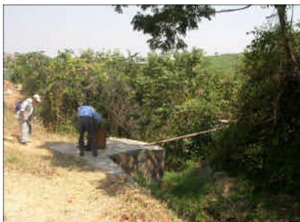
自然流下式水道の水源 4箇所の湧水を集めてこの柵から5セクター の共同水栓へ配水 (ただし、水源のGituku集落 は湧水点より標高が高いので配水できない) ルキラ郡 / Gituku
