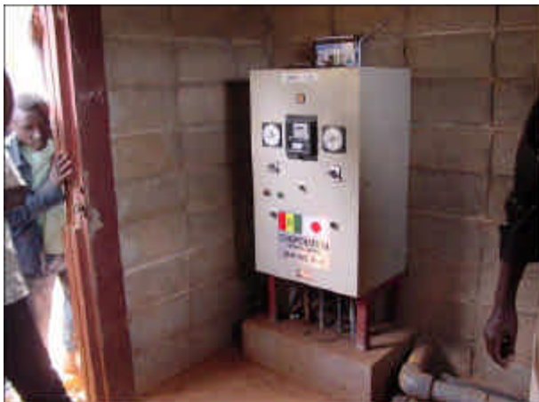
'87無償資金による給水システム(Nyankora) ポンプの制御盤。揚水自動制御は復旧できず 約60m上の給水タンクの水位を確認しながら 手動で運転している。
