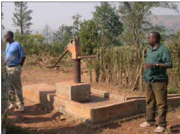
修復要請の故障井戸 ('88年度無償) (-8)
