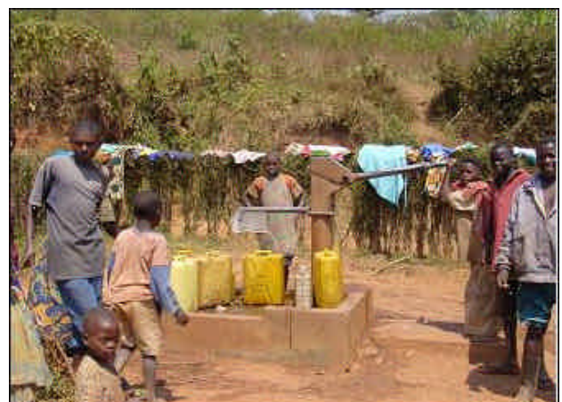
稼働しているハントポンプ('87年度無償, IV-1) 谷沿いに建設された井戸。同時期に建設された 近隣の2井戸が故障しているため、3 Celluleが 利用している。
