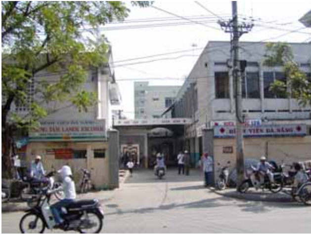
病院玄関 1 (救急外来棟側、内部は常に混雑している)
