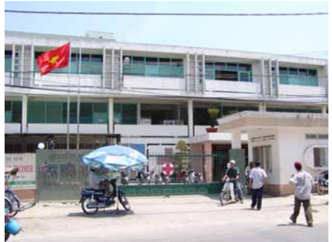
病院玄関 2 (管理棟側)
