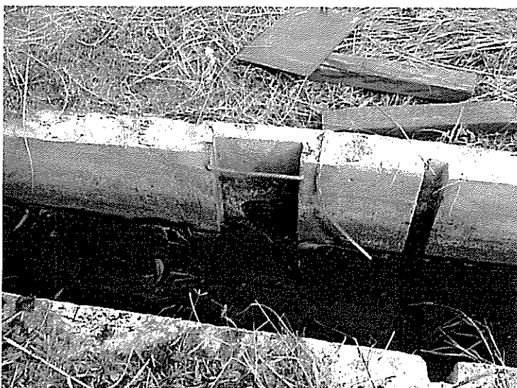
田圃への導水路状況（ジャマラボ）
