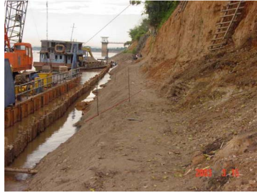
2) Overview of sand embankment level (EL 161.9 m)
