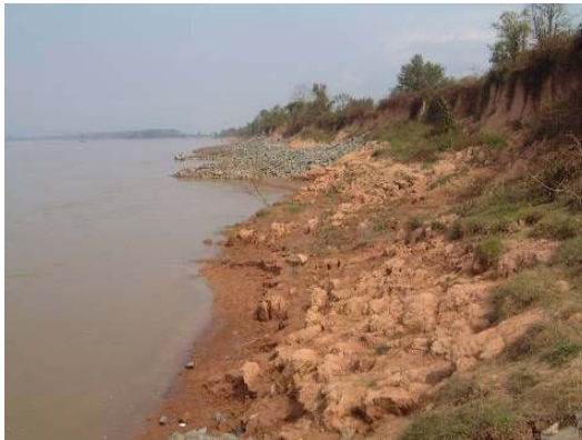
図 2.7 建設継続中のボケオ県の捨石水制工 -2001 年 12 月の状況-
