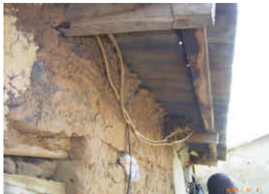
写真 5-3 Kudna 村/Naija 州 電化レベル-4 の村で、コンパウンド内の小 規模配線が行われている。複数のミニグリ ッドが形成されている。
